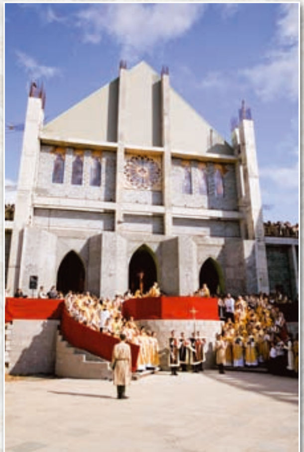
A fachada da igreja de Nossa Senhora do Rosário, ainda em construção, no momento do cortejo de encerramento da cerimônia
