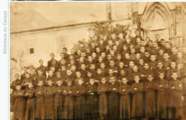
O Colégio Caraça na década de 1920. Acima, vista geral do prédio; embaixo, os alunos internos
